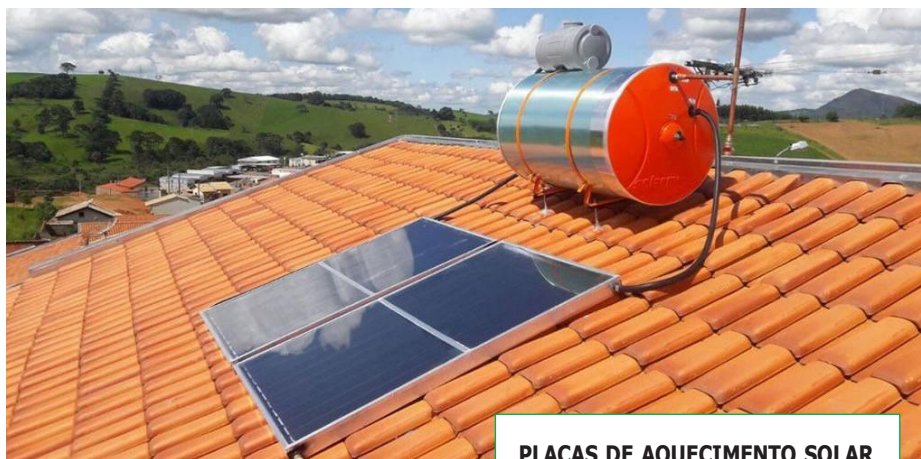
PLACAS DE AQUECIMENTO SOLAR
