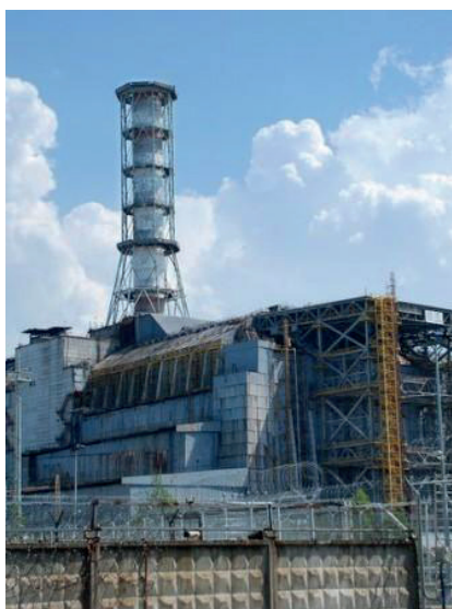
Usina Nuclear de Chernobyl, na Ucrânia. Observe o "sarcófago" de concreto construído para conter a radiação.
