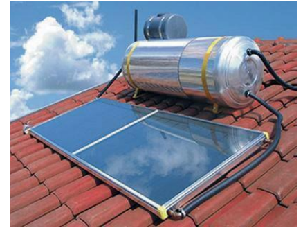
Figura 3. coletor solar. disponível em: < https://mundoeducacao.uol.com.br/fisica/coletor-solar.htm > acesso em 13 jan 2021
